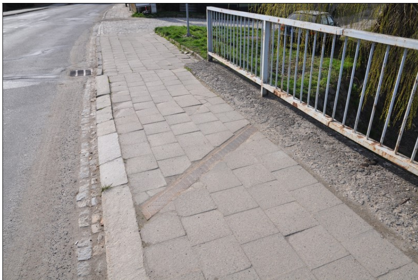
Překrytí dilatace na chodníku nad opěrou 1 vlevo.
