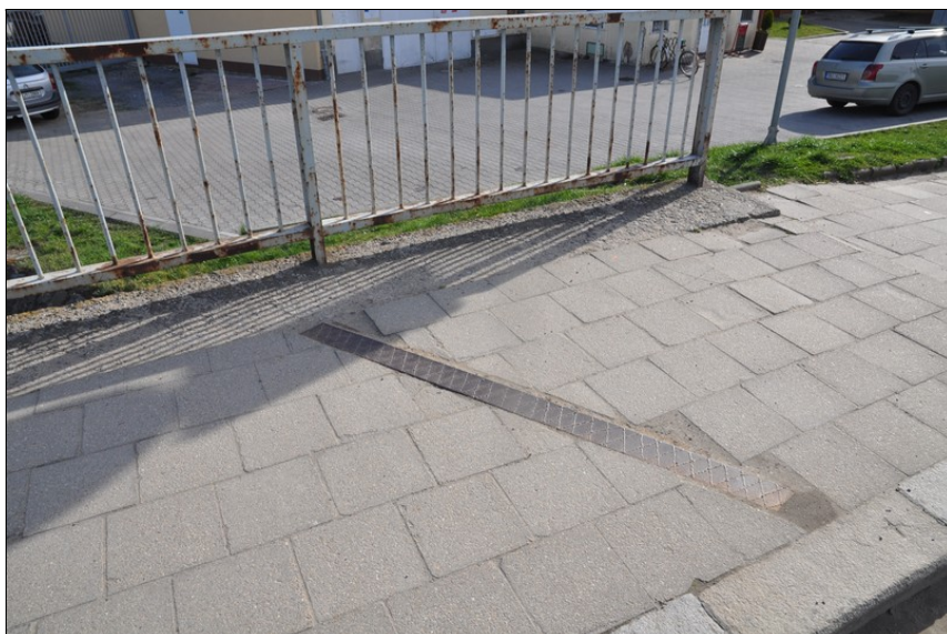
Překrytí dilatace na chodníku nad opěrou 1 vpravo.
