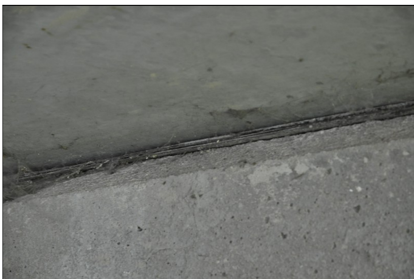
Uložení nosníků KA na lepenku.
