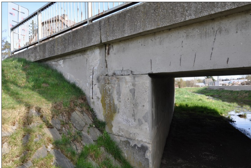
Uložení nosné konstrukce na opěře 2 vlevo.
