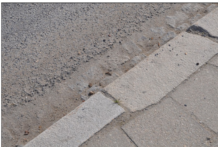
Kamenné obrubníky, přídlažba a opotřebovaný asfaltobeton.
