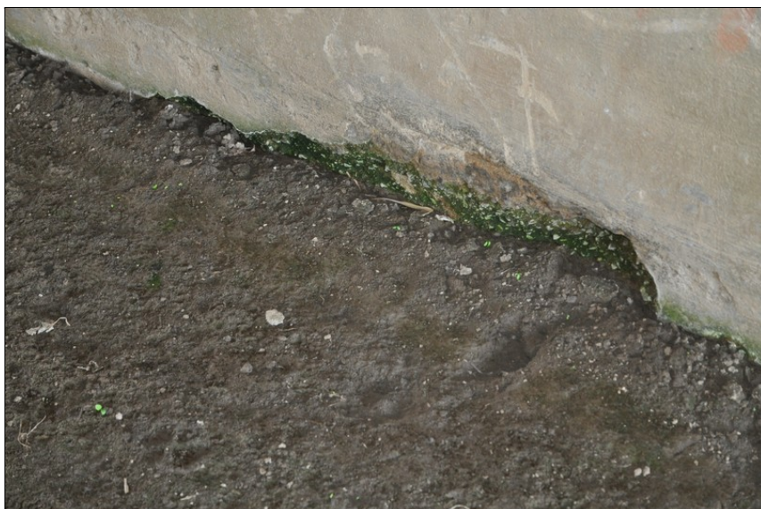
Odmrzání prostého betonu opěry 2.
