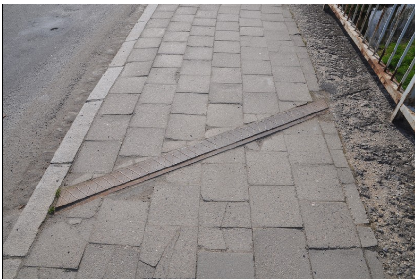
Překrytí dilatace vlevo nad opěrou 2.
