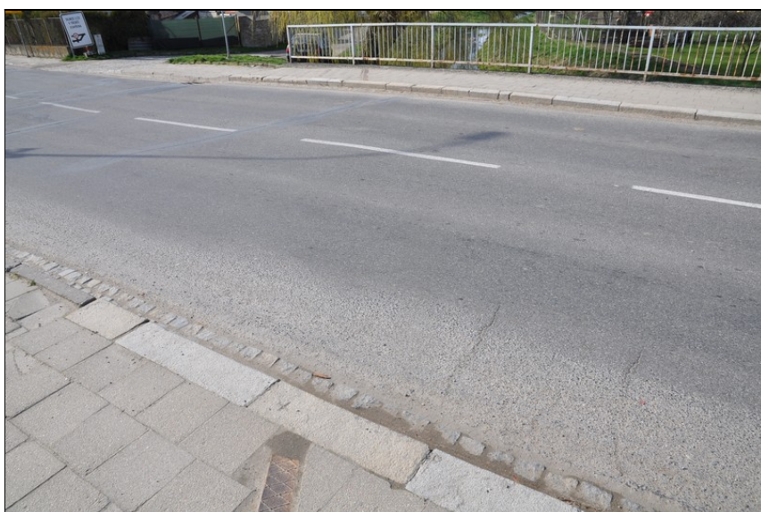
Trhliny ve vozovce vpravo.
