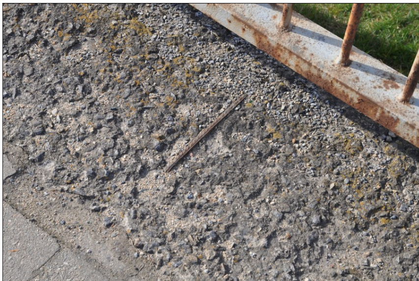
Zdegradovaný beton říms.
