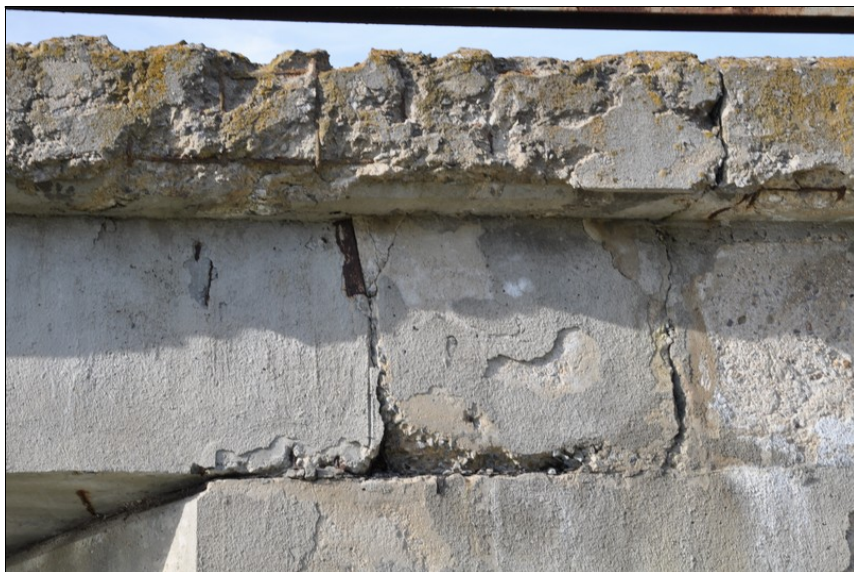
Římsa vpravo v blízkosti dilatace nad opěrou 2.
